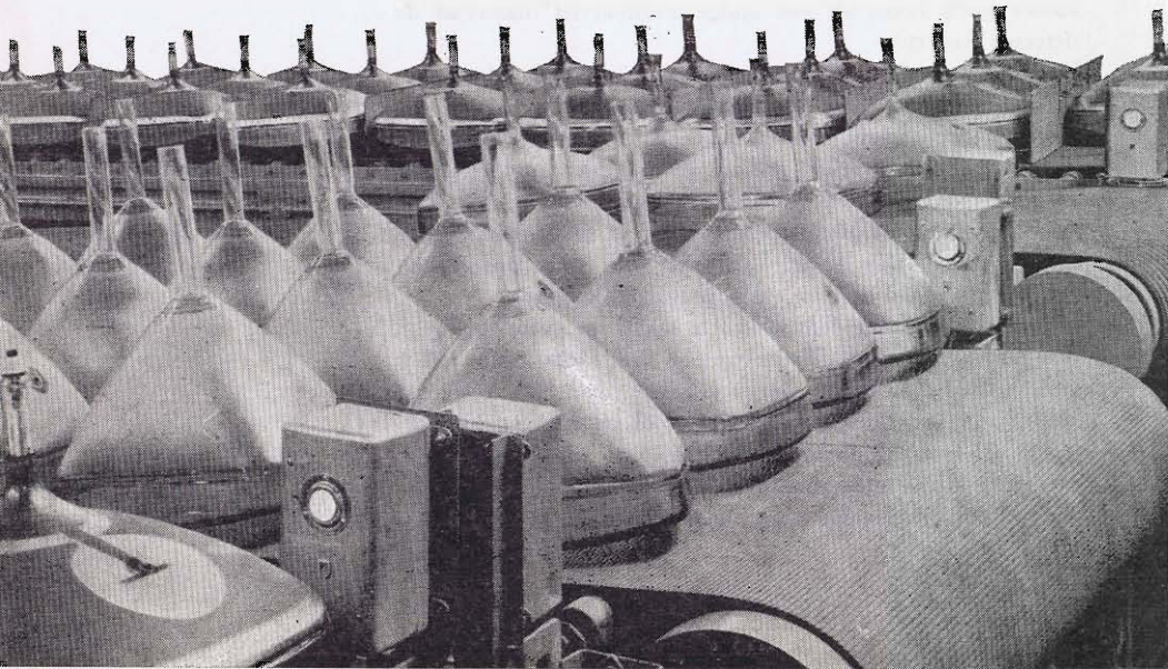
Fig. 15 Fotocellen in gebruik bij transportbanden voor televisie-beeldbuizen
